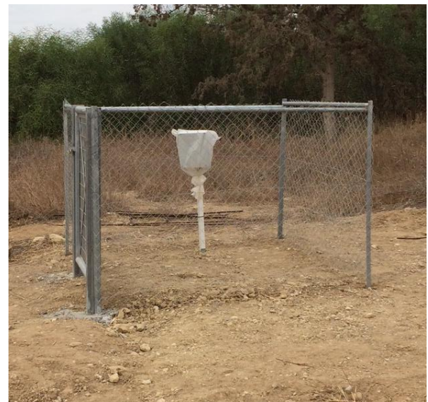
Φωτ. 7. Σταθμός μετρήσεων του Πανεπιστημίου Κύπρου μετά την επανεπίχωση του ερευνητικού φρέατος, την περίφραξη και την στεγάνωση και θερμομόνωση του κλωβού του καταγραφικού.
