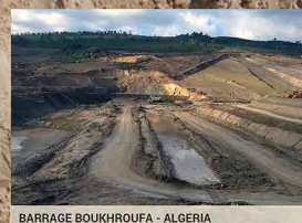
BARRAGE BOUKHROUFA - ALGERIA
