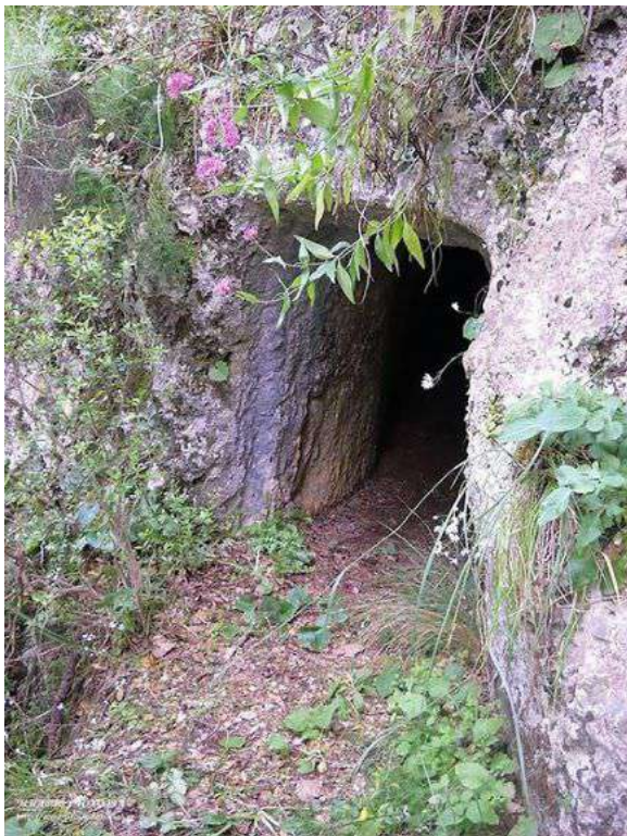
Εικ. Με κατάλληλη τεχνογνωσία, υπομονή και επιμονή, κατασκεύασαν σήραγγα με μήκος περίπου 30μ., ύψος από 1,2μ έως 1,4μ. και πλάτος 0,8μ.
